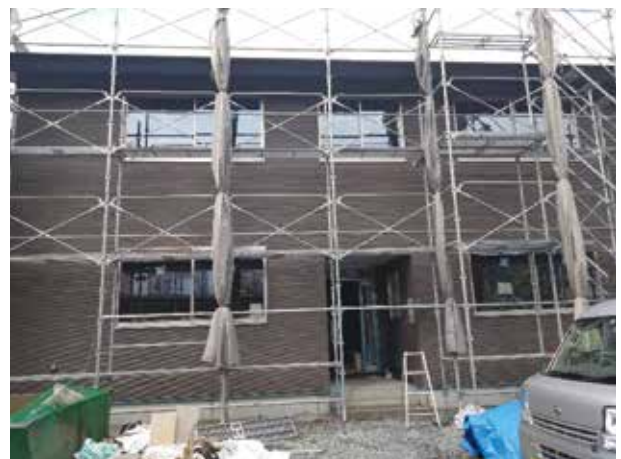
建築工事現場 (令和6年10月23日)
