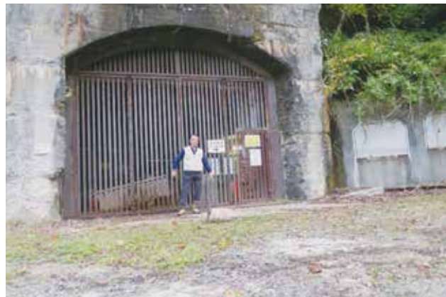
仙人谷ダムの管理施設の出入口
